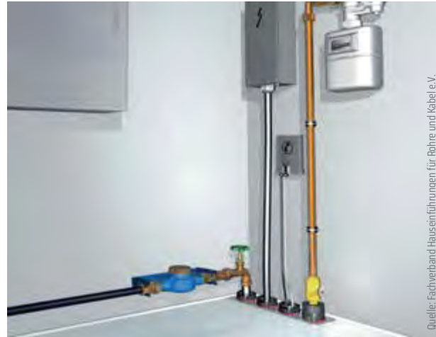
Installation durch die Betonbodenplatte
