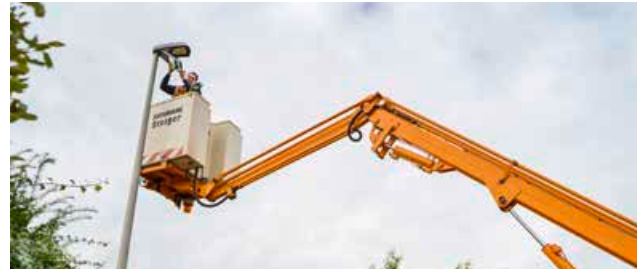
Auf der To-do-Liste des Tages: ein neuer Zähler, ein Baustrom- anschluss, ein Leuchtmittel- Wechsel in luftiger Höhe (von links)
