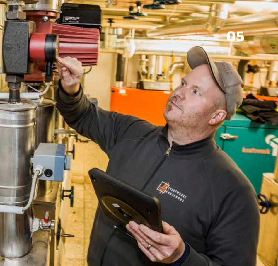
Links: SWB-Mitarbeiter Oliver Holst zeigt das Typenschild an der Heizung, auf dem das Alter der Anlage steht. Oben: Heizungsmonteur Gerd Heckert an der Hocheffizienzpumpe einer Erdgasheizung
