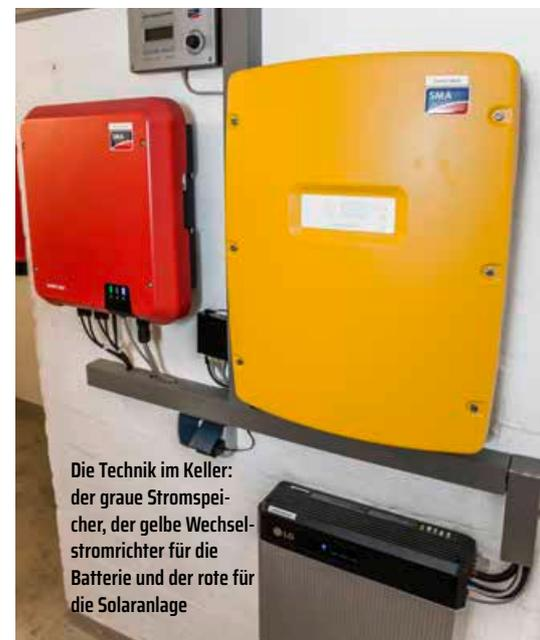
Die Technik im Keller: der graue Stromspeicher, der gelbe Wechselstromrichter für die Batterie und der rote für die Solaranlage
